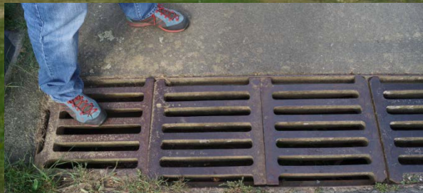
Querrinne mit Ablauf in Kanalisation
