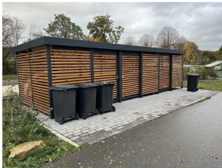
Abb.: Blick auf den Mülltonnensammelplatz (eigene Aufnahme)
